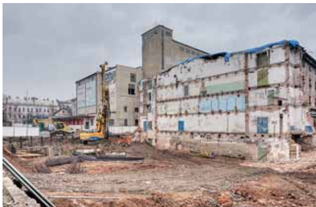
Jeden z nevyužitých průmyslových areálů v Olomouci, kde už dnes stojí základy příštího hotelu Ibis.
